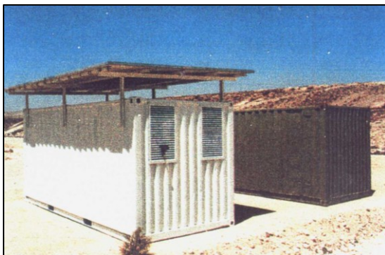
מכולה מקורה עם הפרדת מתרסי מגן (ימין) 9 מכולה "משודרגת" מול רגילה (שמאל) 10
