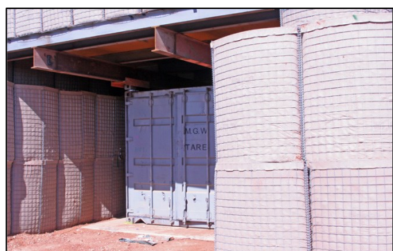
מכולה מקורה עם הפרדת מתרסי מגן (ימין) 9 מכולה "משודרגת" מול רגילה (שמאל) 10
